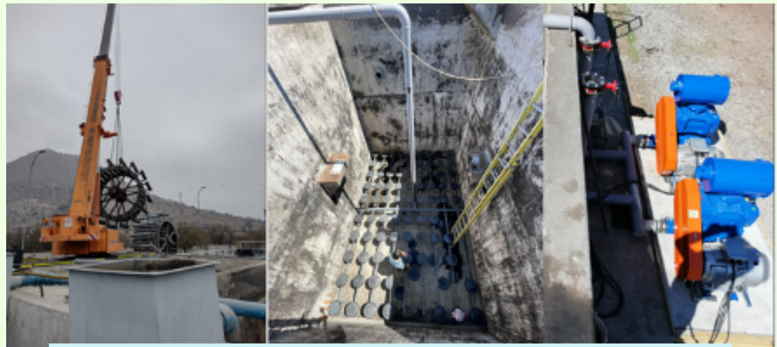
Nuevo sistema de aireación extendida en Planta de Tratamiento de Agua Servida
